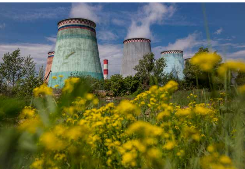
ТЭЦ-26 ПАО «МОСЭНЕРГО»
