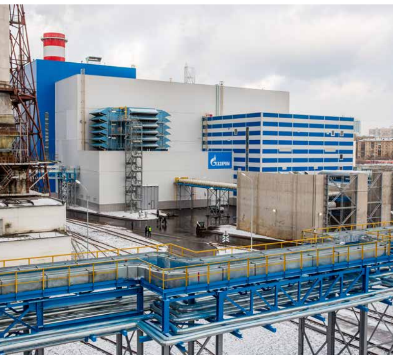
ТЭЦ-16 ПАО «МОСЭНЕРГО»
