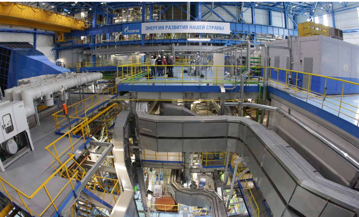
МАШИННЫЙ ЗАЛ ЭНЕРГБЛОКА ПГУ-220 ТЭЦ-12 ПАО «МОСЭНЕРГО»
