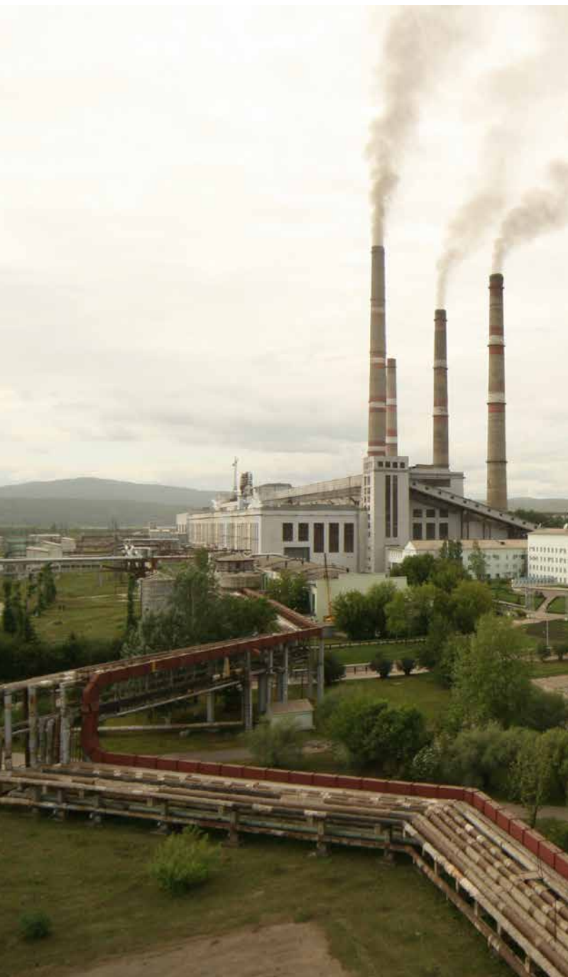
КРАСНОЯРСКАЯ ГРЭС-2 ПАО «ОГК-2»
